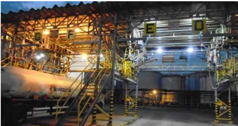
Estação de carregamento com luminárias vapor de sódio 250w versus LED 50w
