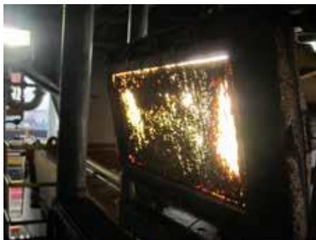
Luminária recoberta de sujeira aumento do risco de radiação ótica
